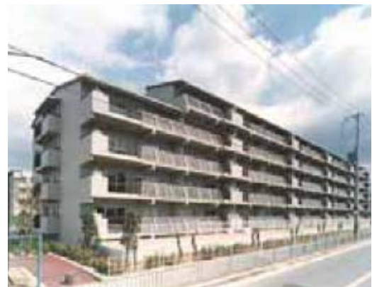
大阪府北助松団地 (新エネガイド) (集合住宅ベランダ 4.48 m 2 ×85台 真空管)
