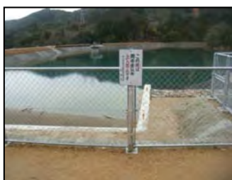
警告看板の設置
