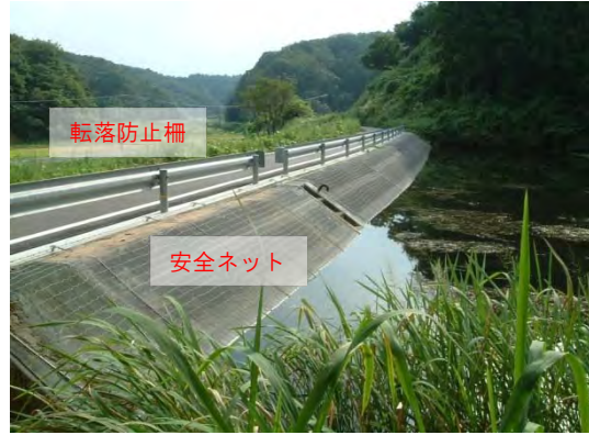
堤体法面に設置した安全ネット
