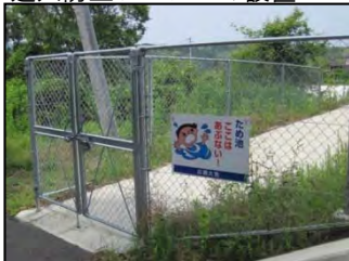
進入防止フェンスの設置
