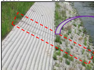
昇降チェーンの設置
